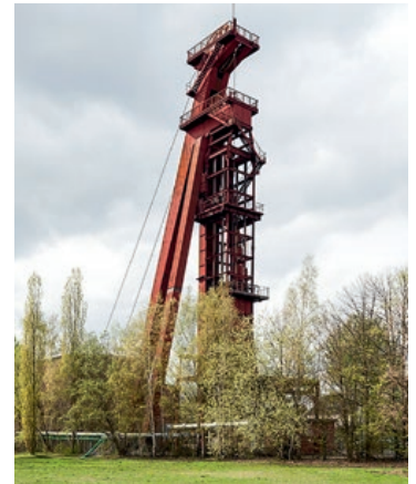
Das weithin sichtbare Wahrzeichen der ehemaligen Zeche
